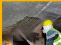
RÉPARATION DU BÉTON
