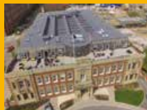
TOITURE À SIMPLE COUCHE
