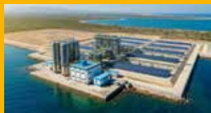
STATION DE DESSALEMENT
