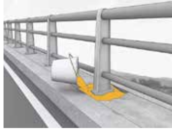
REMPLISSAGE DES JOINTS D'ASSISE DANS LES SECTIONS EN BÉTON PRÉFABRIQUÉ
