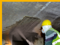
RÉPARATION DU BÉTON
