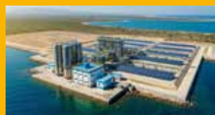
STATION DE DESSALEMENT
