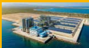
STATION DE DESSALEMENT
